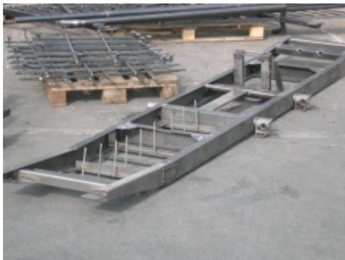
Bild 9: Die Bodenplatte ist fertig geschweißt.
