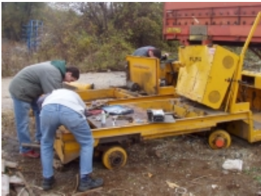
Bild 14: Von 2 alten Paketwagen werden Motor und Steuerung ausgebaut
